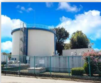
写真1 多和目配水場外観
