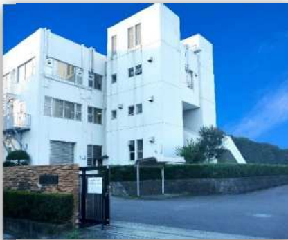
写真2 鶴ヶ島浄水場外観
