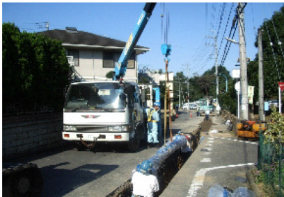
配水管布設工事
