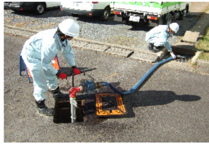
配水管布設工事に伴う排水作業
