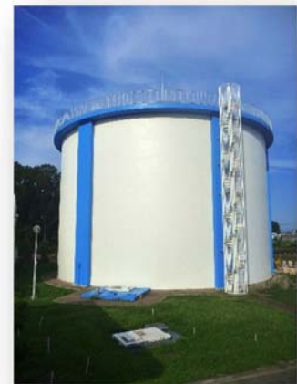
鶴ヶ島浄水場 P C 配水池
