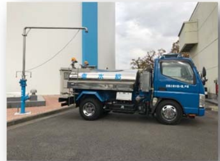
緊急時給水栓と給水車
