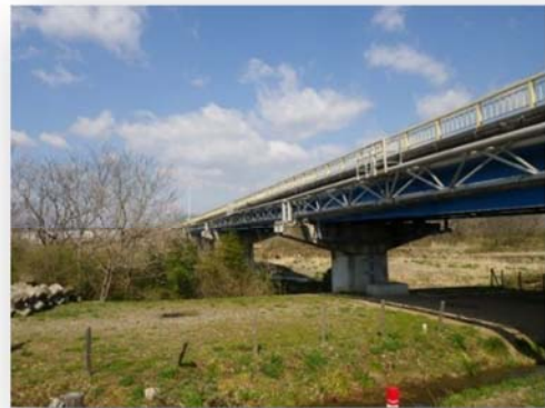
万年橋の水管橋
