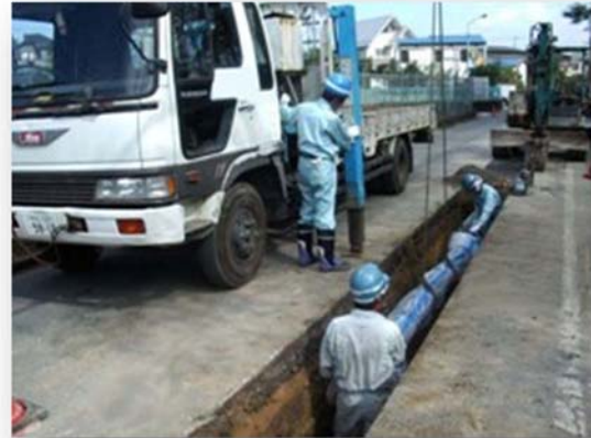
管路の更新工事
