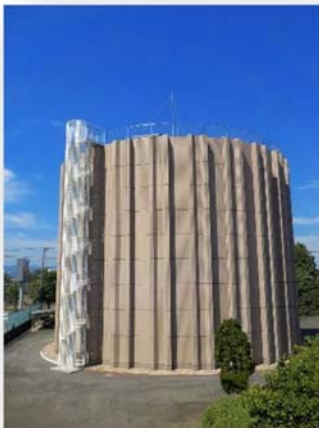
坂戸浄水場 P C 配水池
