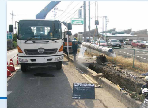
耐震性のある配水管の施工
