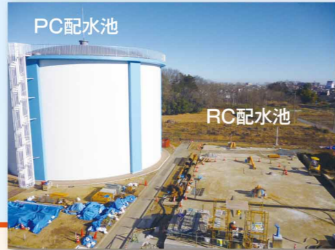
RC配水池改修工事の様子
