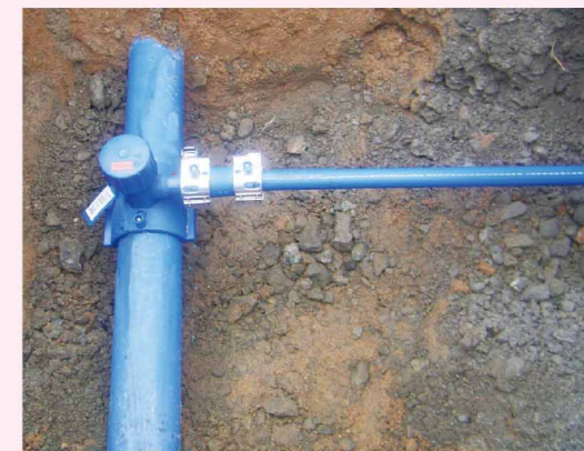
耐震性のある給水管の施工
