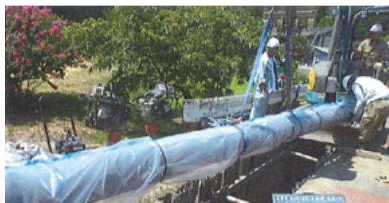
管路の布設替工事の様子 (税込)
